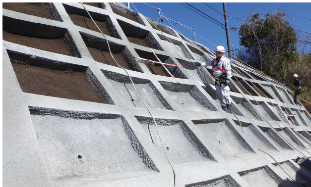
神奈川県厚木土木事務所津久井治水センター 根小屋B地区 急傾斜地崩壊対策工事(相模原市)
