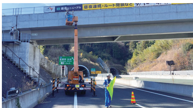
橋りょう点検
