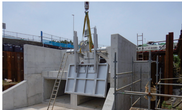
大磯町 三沢川樋門整備工事(平塚市)
