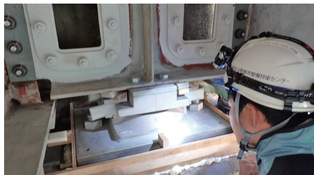
橋りょう補修工事(支取替)
