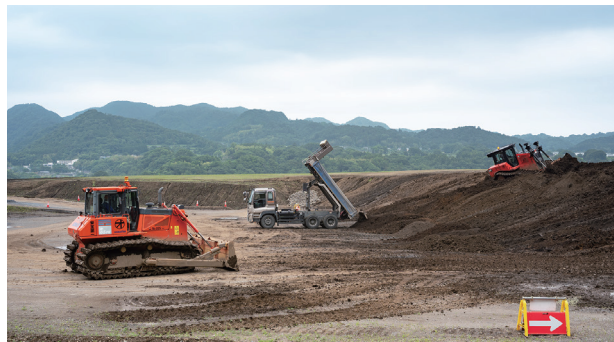
建設発生土の搬入状況(田代受入地)
