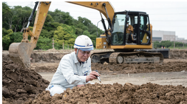
土砂搬入確認状況
