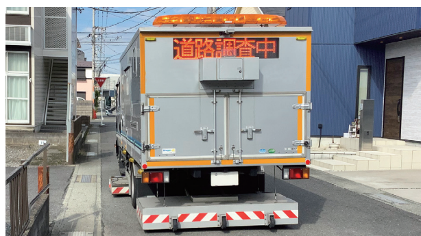
路面下空洞調査
