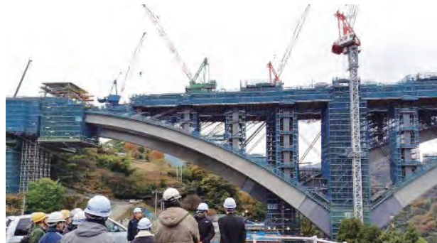
現場研修（新東名高速道路建設現場）
