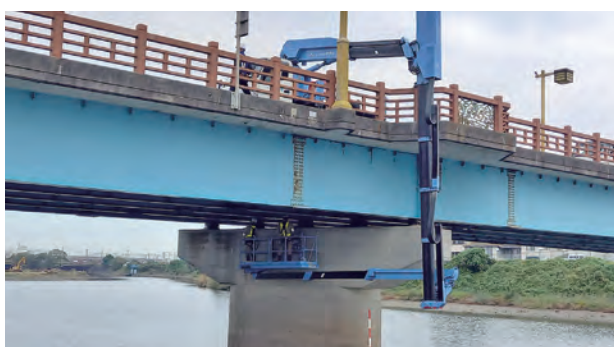
橋りょう点検
