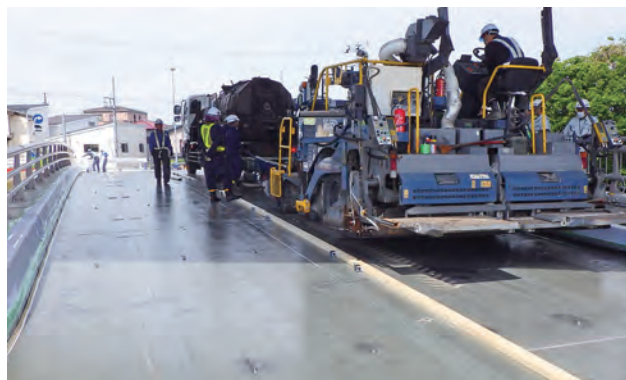
茅ヶ崎市 浜園橋架替工事(橋面舗装工)
