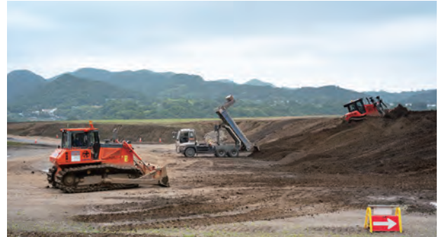
建設発生土の搬入状況(田代受入地)
