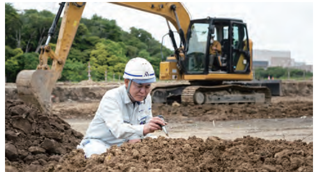
土砂搬入確認状況
