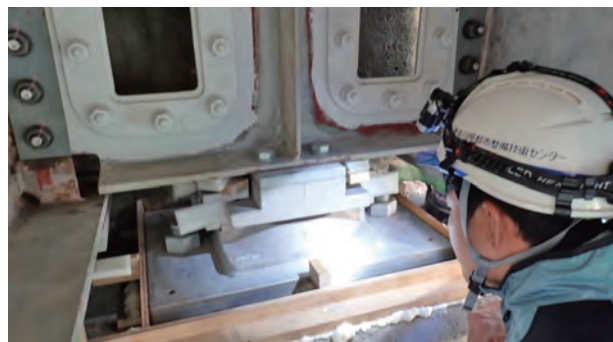
橋りょう補修工事（支取替）
